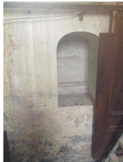
Lavabo liturgique mis à jour derrière le lambris du chœur
