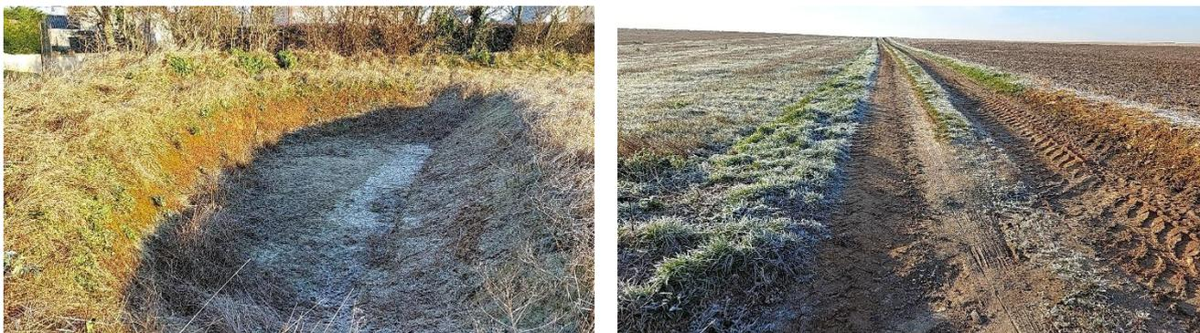
**Figure 20 – Vue sur le bassin B1 et le caniveau grille obstrué**
